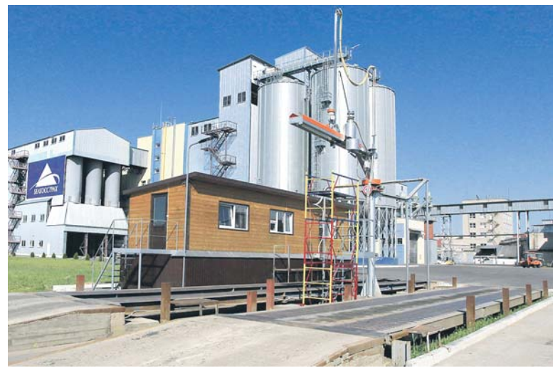
Предприятие готово к встрече урожая-2016. Пневматический отборник зерна способен обслужить сразу два автомобиля.
